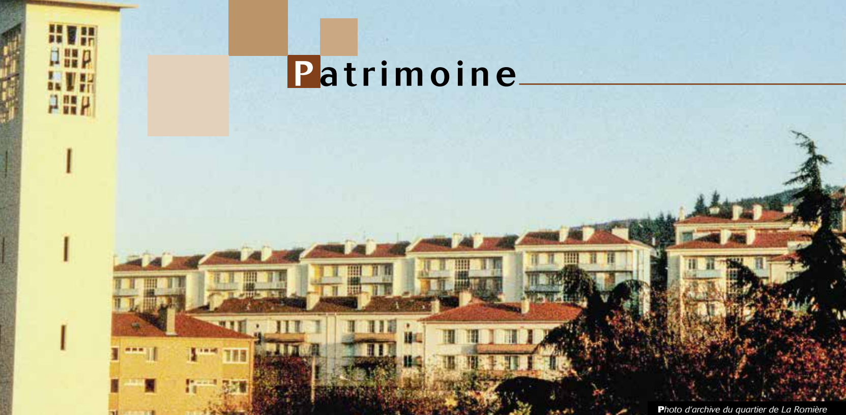
Photo d'archive du quartier de La Romière
