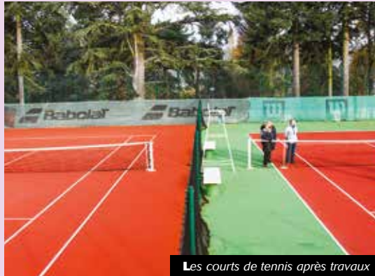
Les courts de tennis après travaux
