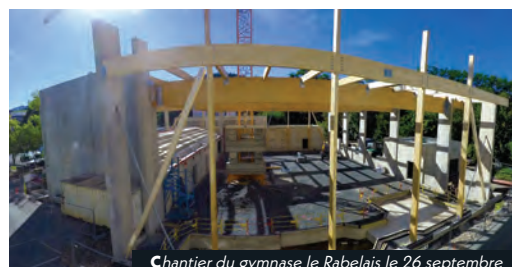
Chantier du gymnase le Rabelais le 26 septembre
