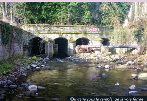
Ouvrage sous le remblai de la voie ferrée
