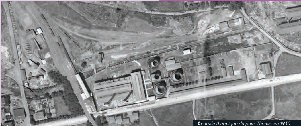
Centrale thermique du puits Thomas en 1930
