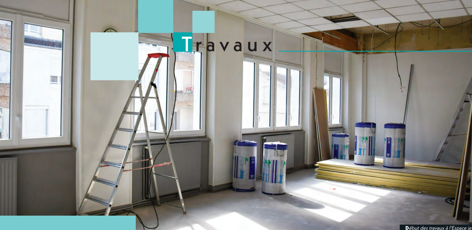
Début des travaux à l'Espace jeunesse
