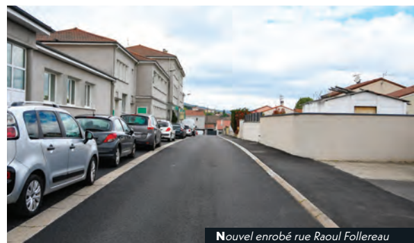
Nouvel enrobé rue Raoul Follereau
