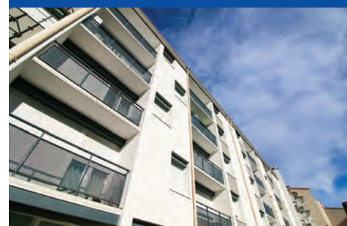
Les garde-corps Batisolu installés au 79 rue de la République
