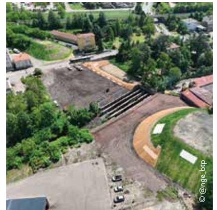
**villelechambon** Prenons un peu de hauteur sur les travaux secteur La Bargette-République ! La première phase de suppression du remblai de l'ancienne voie ferrée et du viaduc enjambant la rue de la République et l'Ondaïne sont terminés.
