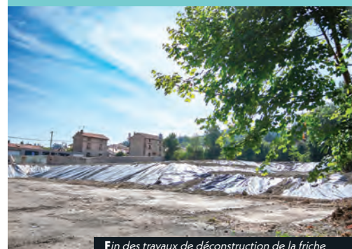
Fin des travaux de déconstruction de la friche
