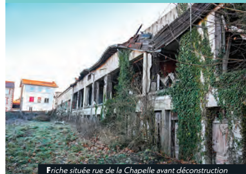
Friche située rue de la Chapelle avant déconstruction
