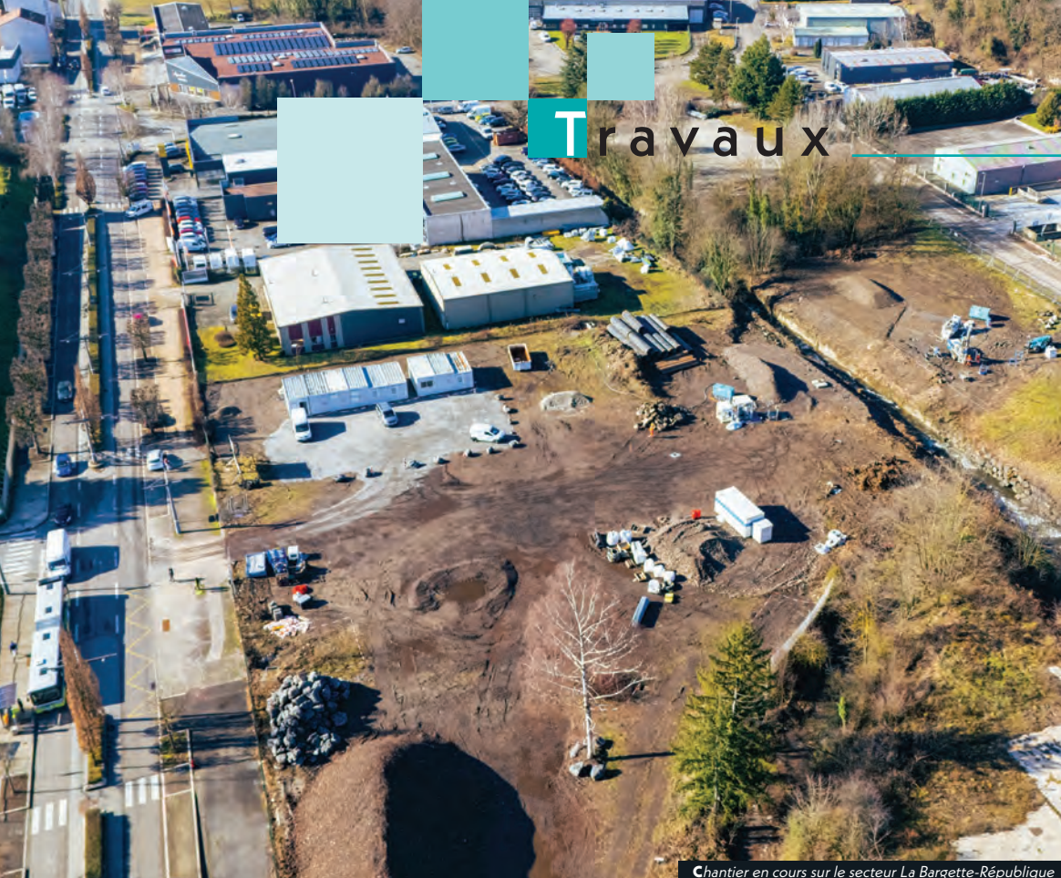
Chantier en cours sur le secteur La Bargette-République
