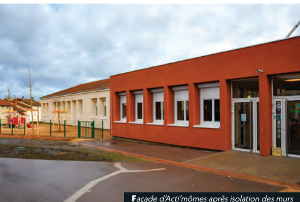
Façade d'Acti'mômes après isolation des murs
