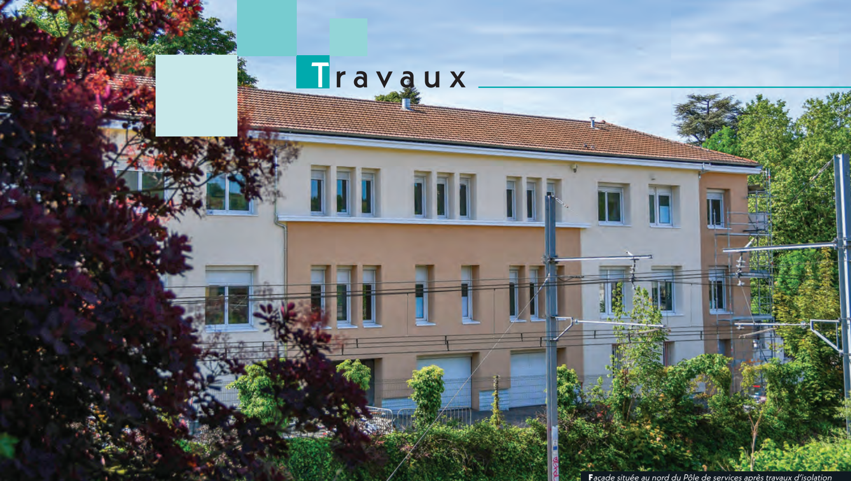
Façade située au nord du Pôle de services après travaux d'isolation
