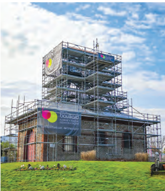
Le Puits du Marais a fait peau neuve. Des travaux de nettoyage et de peinture ont été réalisés pour lui redonner tout son éclat.
