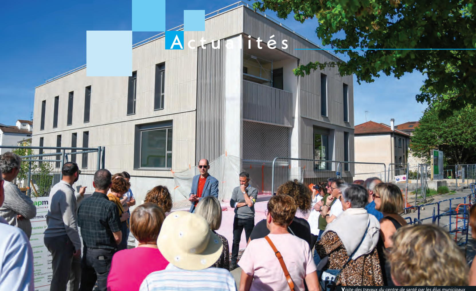
Visite des travaux du centre de santé par les élus municipaux
